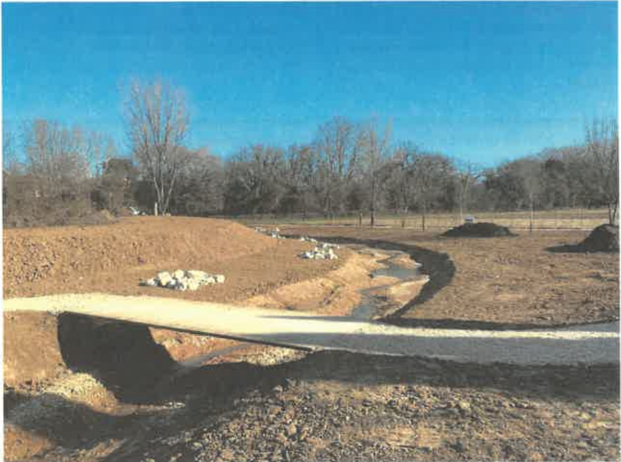
Photo de la passerelle
